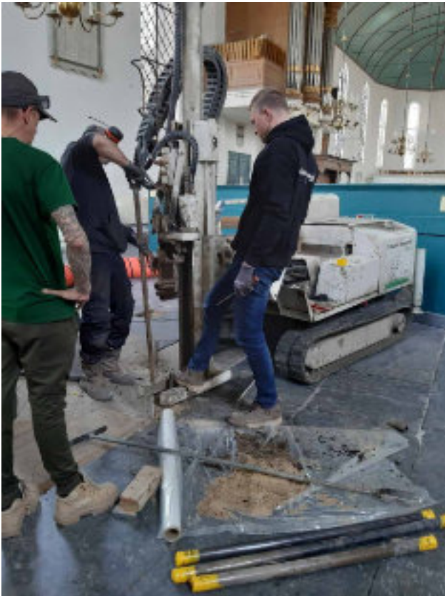
Foto OK-07 Sonicdrill boring in uitvoering. Op de voorgrond de gestoken kernen.
