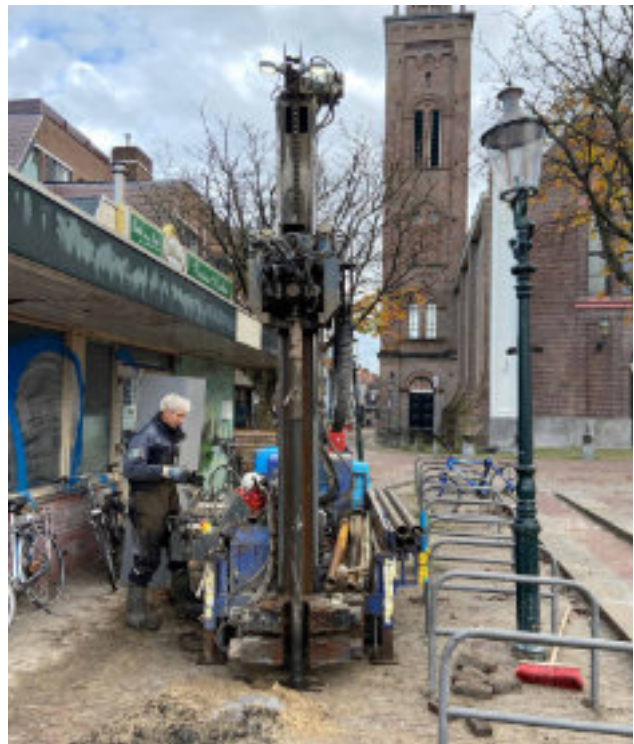
Foto WS-06 De boorinstallatie van SialTech Europe, waarmee in het najaar van 2020 de sonicdrill boringen aan de oostzijde van de Dam in Zaandam werden uitgevoerd.
