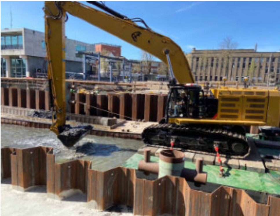
Foto WS-08 De baggerwerkzaamheden voorjaar 2020. Per sector werd tot een vooraf bepaalde diepte gebaggerd, waarna de vrijgekomen grond naar de zeeflocatie werd vervoerd.
