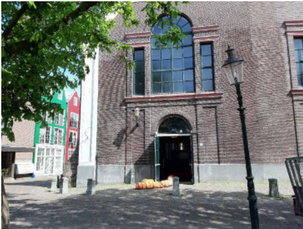
Foto OK-01 Ingang van de Oostzijderkerk aan de Zuidijk.
