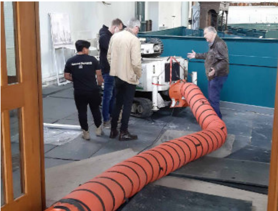
Foto OK-04 Afvoerslang voor de diesellucht van de boormachine.
