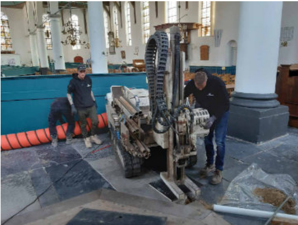
Foto OK-06 Plaatsen van de boormachineboven het boorgat.
