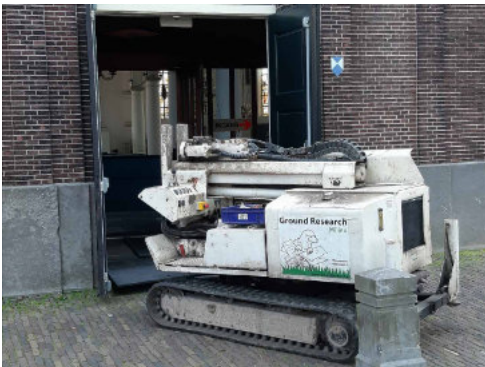
Foto OK-02 Sonicdrill machine van Ground Research uit Wormerveer bij de ingang van de Oostzijderkerk.
