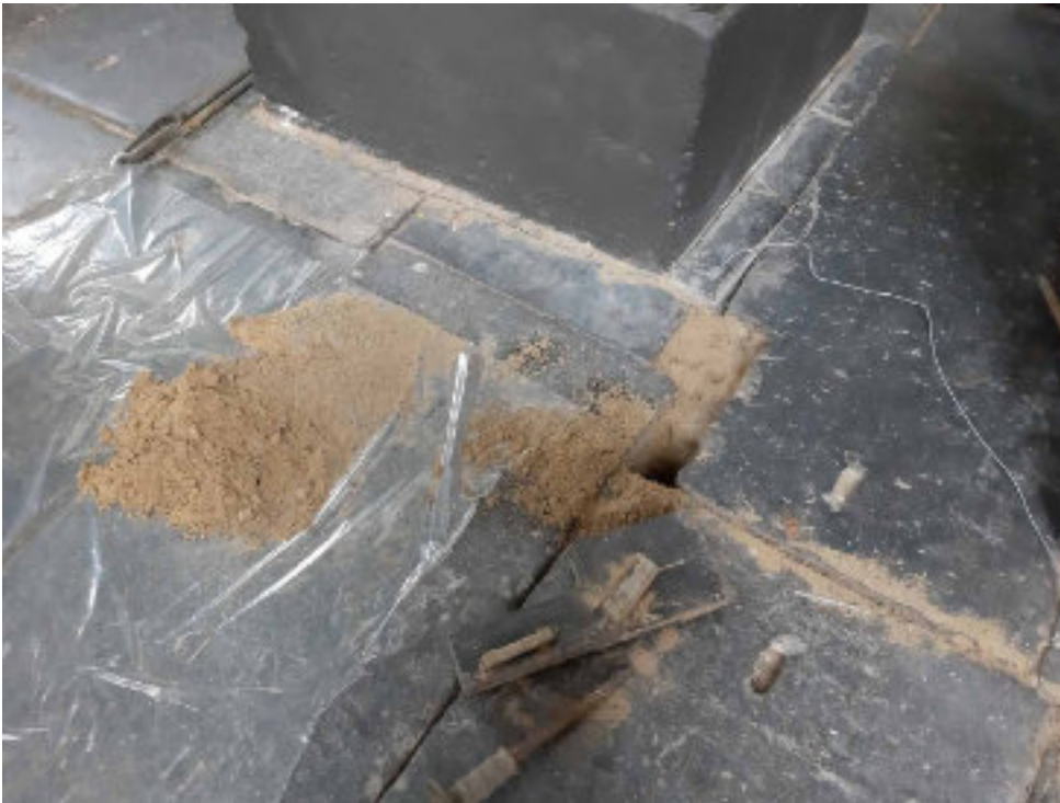
Foto OK-05 Ophoogzand onder de kerk uit het voorgeboorde gat met de Edelman boor.
