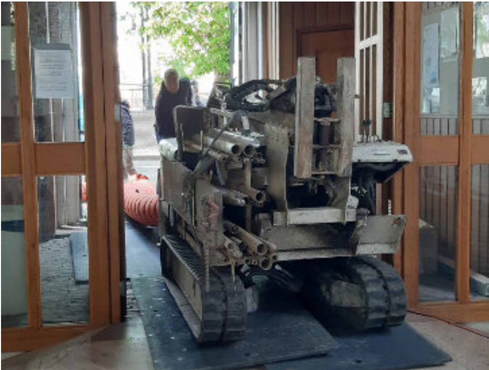
Foto OK-03 De sonicdrill machine wordt de kerkingereden op beschermplaten om beschadiging te voorkomen.
