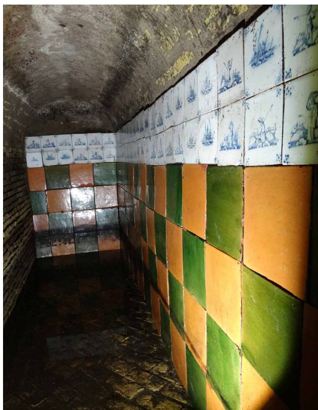
Afb. 3.64 De cisterne onder de vloer van de huidige boerderij Ter Coulster Hof. [foto: Landgoed ter Coulster]
