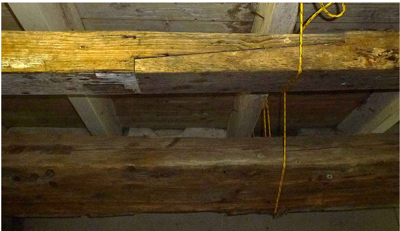
Afb. 3.69 Detail van houten balk met schuine lasverbinding (M3) en daarachter balk met pengaten (M2) afkomstig van onder de vloer in de woonkamer van Ter Coulster Hof, hangend in het koetshuis. [foto: Lange 2019]
