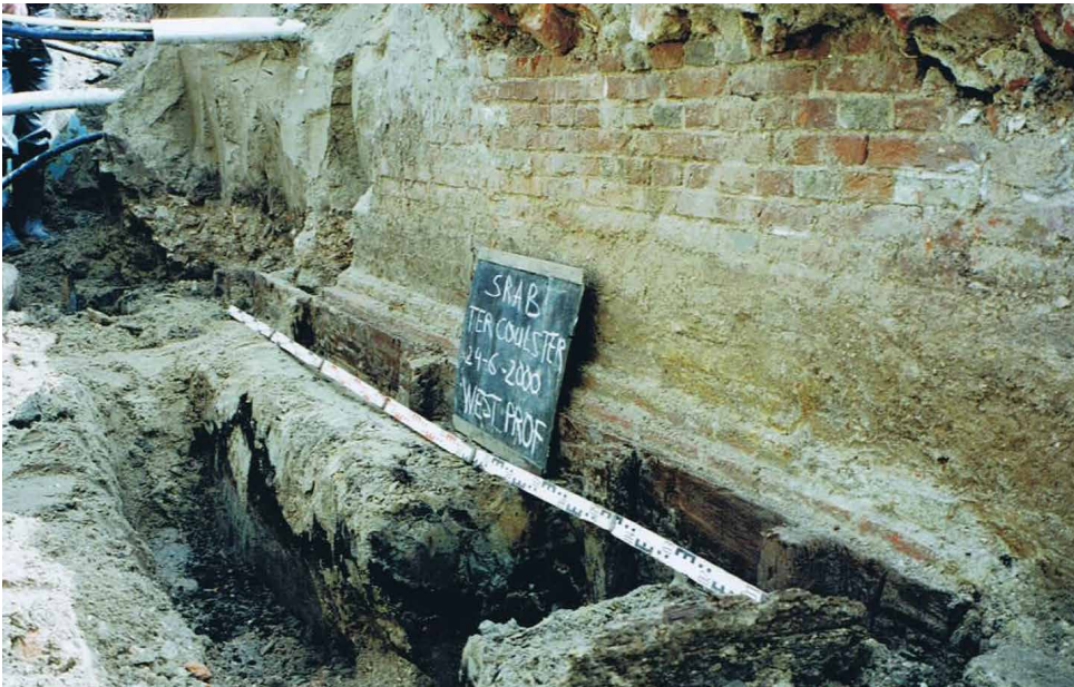
Afb. 3.22 De in 2000 opgegraven westmuur met houtwerk eronder, spoor 10 (vanuit het zuidwesten). [foto: Baduhenna]
