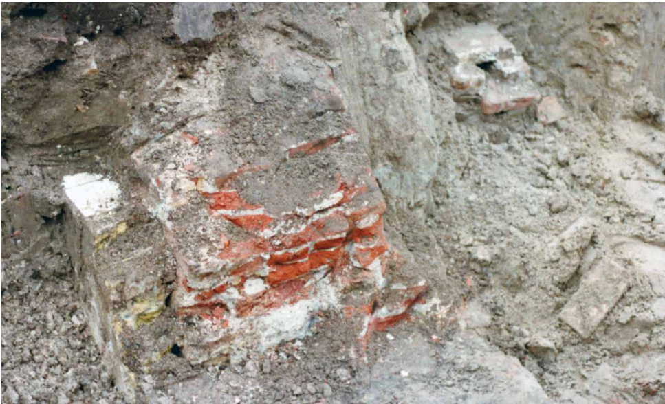
Afb. 3.15 Onderzoek 1983: fundering spoor 3 en rechts daarvan rioolkoker spoor 7 (vanuit het zuidwesten). [foto: PDANH]
