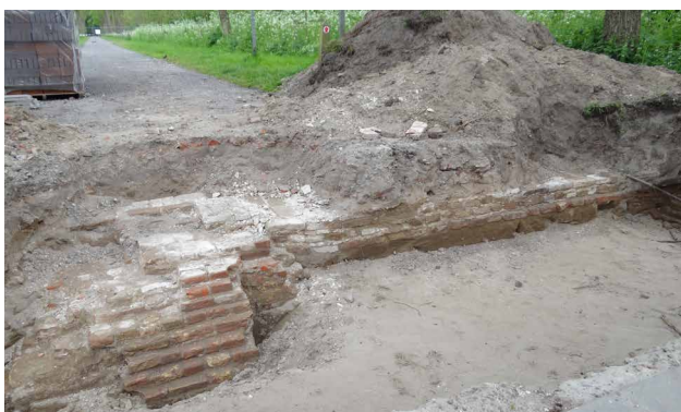
Afb. 3.27 De fundering van de inrijpoort (vanuit het westen). [foto: Hopman 2015, foto 1]
