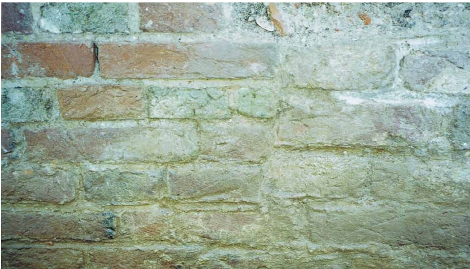
Afb. 3.23 Detail van spoor 10 in 2000: rechts het oudste muurwerk en links een later stuk baksteenmetselwerk van iets kleinere bakstenen (vanuit het westen). [foto: Baduhenna]
