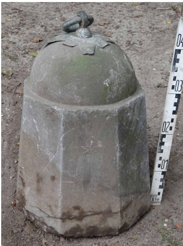
Afb. B4-8 Hardstenen achtkantige kolom met bronzen ring en beslag. [foto: Landgoed Ter Coulster]
