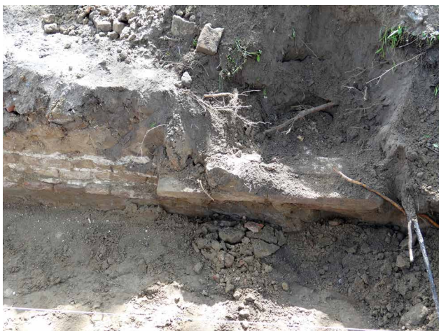
Afb. 3.32 Detail van het verbindingsdeel met los gelegde bakstenen (vanuit het westen). [foto: Hopman 2015, foto 5]
