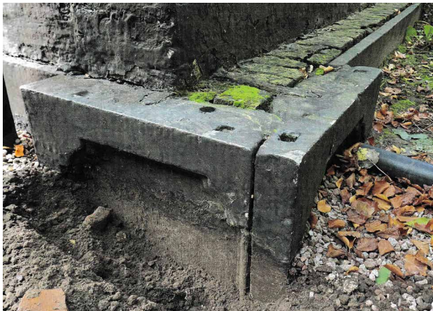
Afb. 3.65 De noordoosthoek van de huidige boerderij Ter Coulster Hof, met een uitstekende rand van middeleeuws muurwerk, met daartegenaan een natuurstenen beplating (vanuit het noordoosten). [bron: De Graaf 2023, 31]
